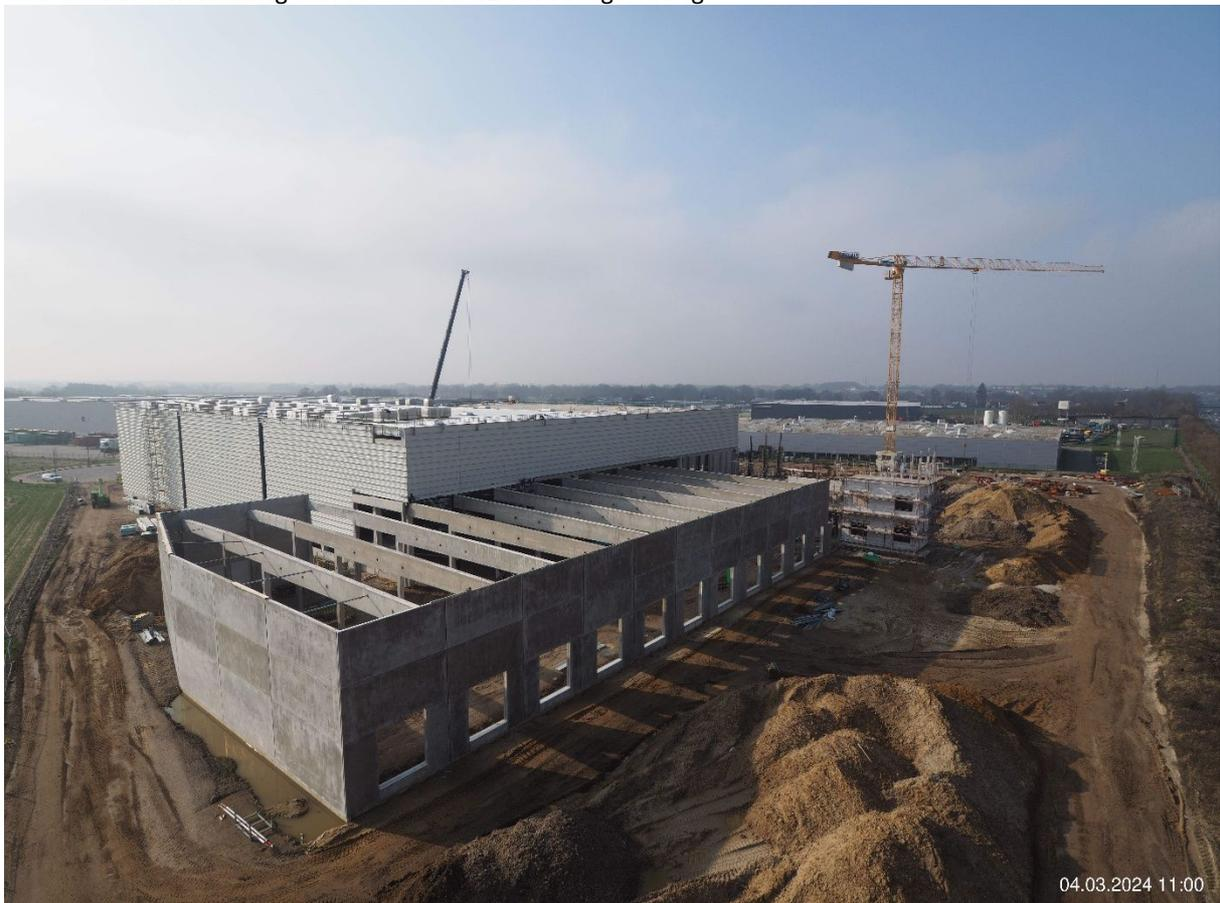
Seit April wird nun auch der letzte große Teil des Logistikzentrums in Angriff genommen. Durch die Montage des Hochregallagers bekommt man einen Eindruck über die finale Höhe des Gebäudekomplexes. Um die Kapazität des vollautomatischen Lagersystems zu erhöhen, wurde das Regal zudem um ca. 4 m in den Boden gebaut.
