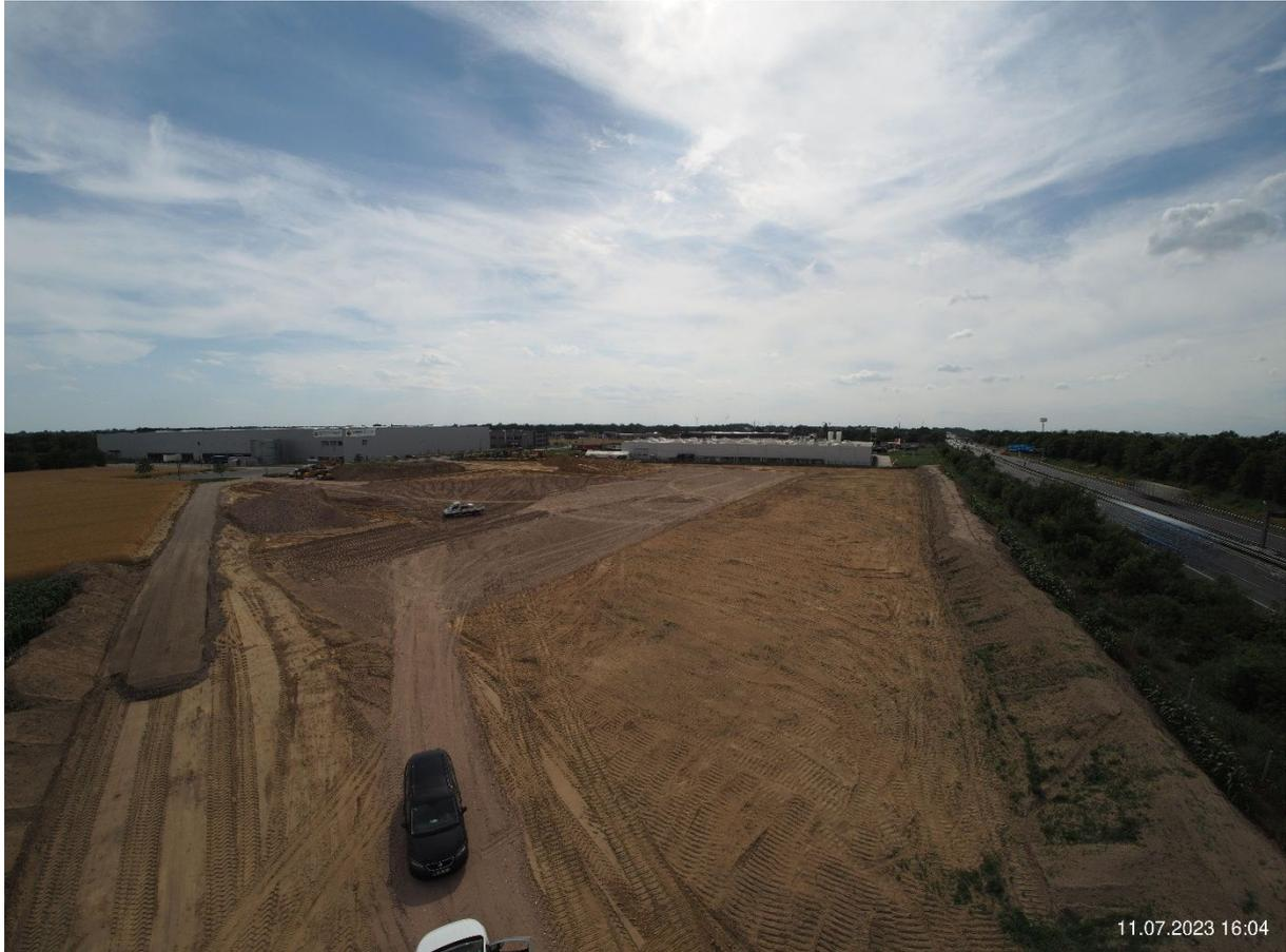
Für das vollautomatische Hochregallager entsteht eine ca. 4 m tiefe Baugrube. Hierfür müssen etliche tausend Kubikmeter Material bewegt werden.
