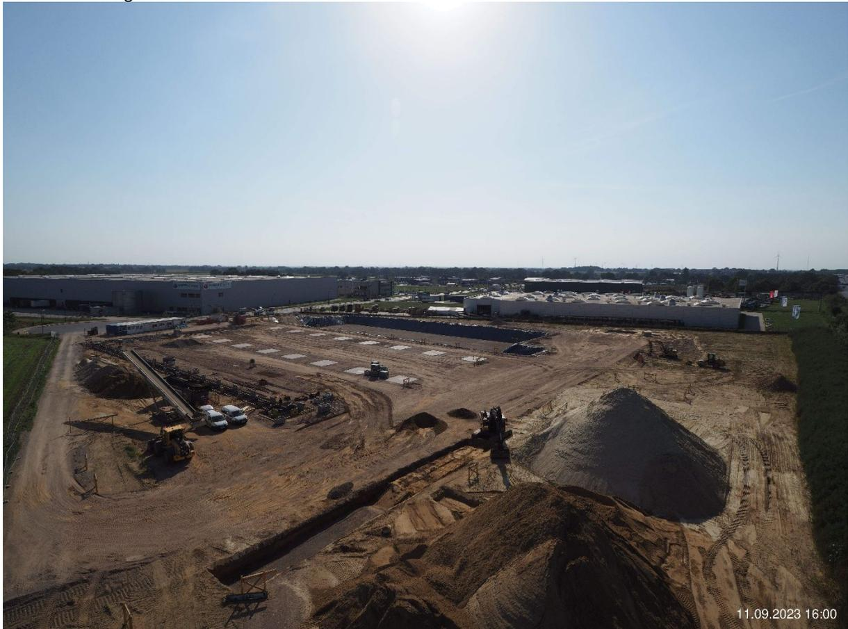
Anfang Oktober herrscht reges Treiben auf der Baustelle. Die Betonarbeiten sind in vollem Gange. Im Bereich des Hochregallagers ist eine Baugrundverbesserung notwendig. Daher werden die benötigten Pfähle mittels Pfahlbohrmaschine in den Untergrund eingebracht.
